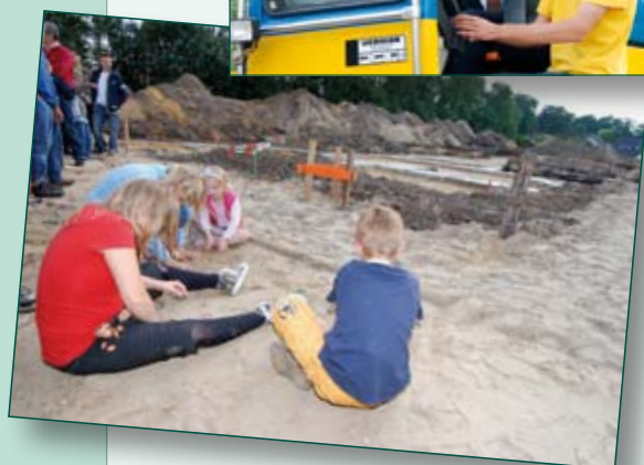
De officiële bouwstart in de eerste fase van Blankensgoed.
