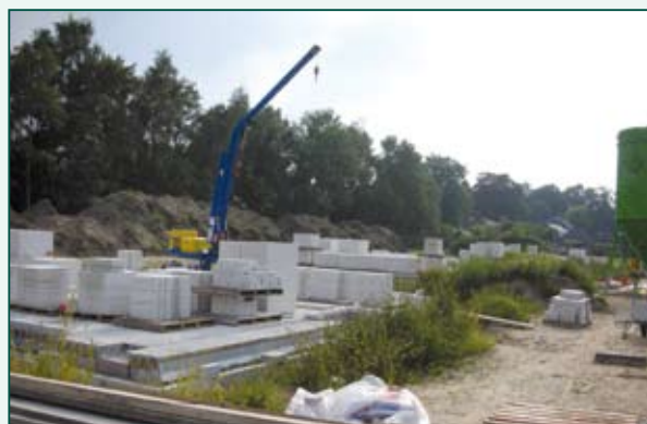
Impressie van de eerste fase in aanbouw.
